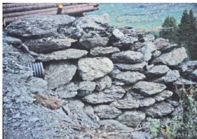
Figur 20. Stikkrenne med steinsetning og trapper i utløpet. Foto: Truls-Erik Johnsrud.
