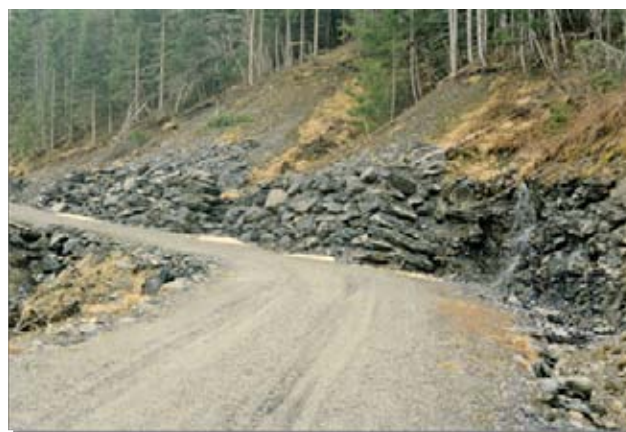
Figur 10. Motfylling og steinsetting av bekkeløp i skredjord av fyllitt. Foto: Truls-Erik Johnsrud
