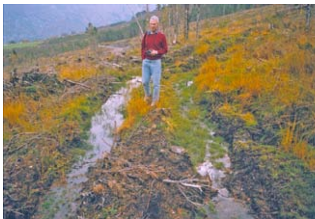
Figur 30. Utflating av kjøresporene. Foto: Nils Olaf Kyllø.
