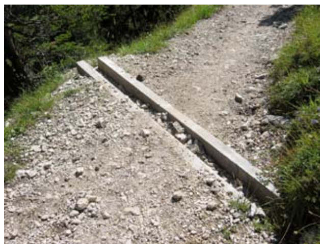
Figur 3. Eksempel på bruk av teregne for å hindre erosjon fra overflatevann. Foto: NGL.
