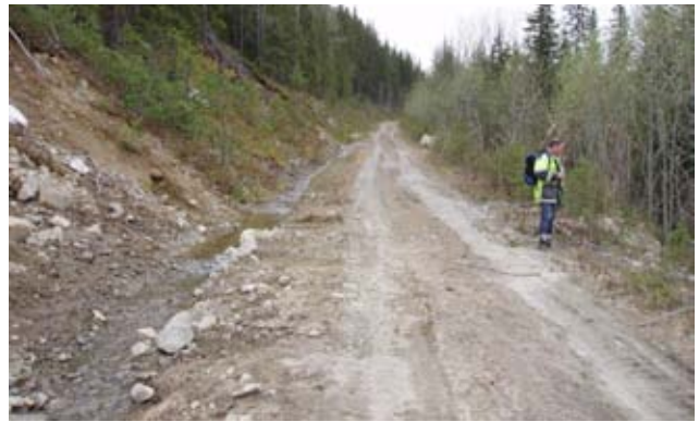
Figur 5. Skogsvegen skrår lia på en lengre strekning. Mye av nedbøren går som diffust sig ned lia. Ved bygging av skjæringer avskjæres både overflatevann og grunnvannsiget i løsmassene. Vannet får dermed en annen fordeling nedenfor vegen enn opprinnelig. Dessuten vil masser fra skjæringene lett kunne fylle grøfta og tette kulverter. Foto: NGI.
