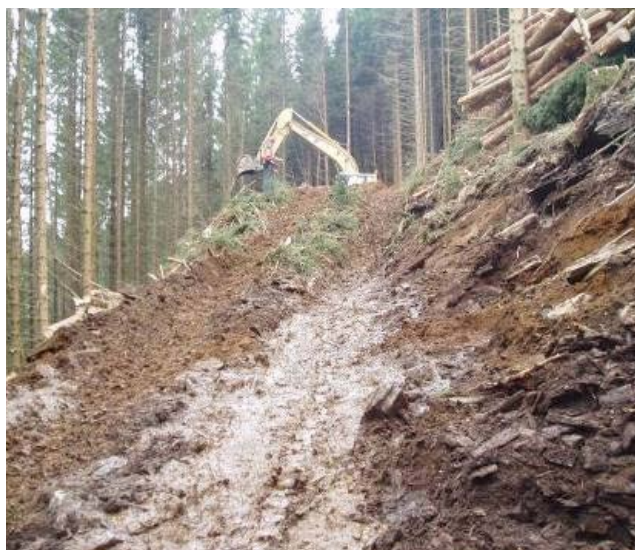
Figur 28. Driftsveg – skogsdrift med gravemaskin, hogstmaskin og lastetraktor i bratt terreng. Foto: Norsk institutt for skog og landskap.
