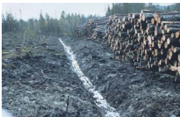
Figur 31. Reparasjon av kjøresporene etter terrengkjøring, figur27. Grøften ble drenert ut i ei myr. Foto: Nils Olaf Kyllø.
