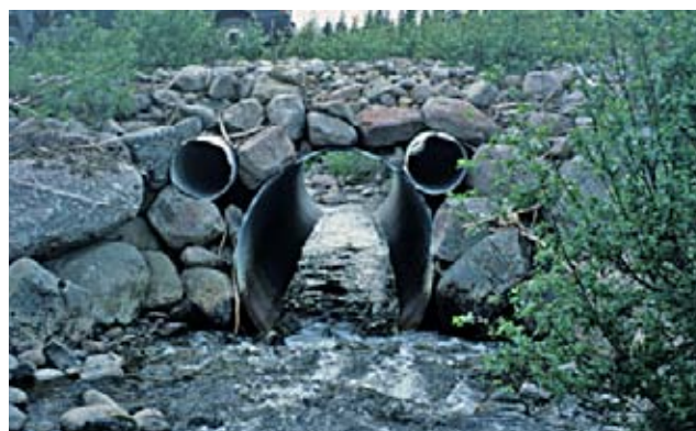
Figur 22. Kulvert i bekk med overløp. Foto: Truls-Erik Johnsrud.
