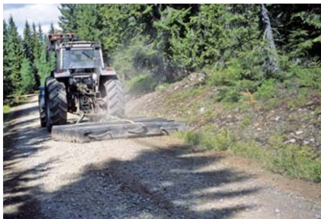
Figur 34. Drammensslodden, et effektivt og billig redskap til forebyggende vegvedlikehold. Foto: Truls-Erik Johnsrud.
