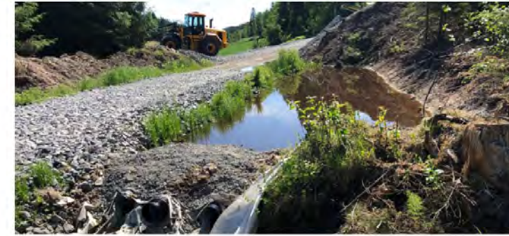
Et eksempel på en fangdam etablert i forbindelse med et massetak etablert langs med en landbruksvei under bygging. Foto: Martin Bråthen/Skogkurs
