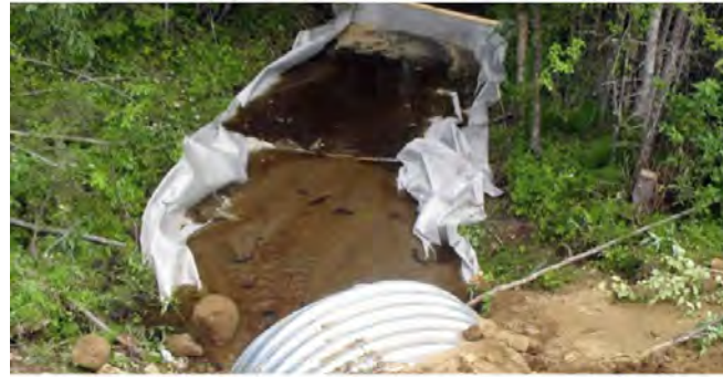
Et eksempel på en sedimentfelle med fiberduk. Fiberduken bør legges dobbelt for å unngå at duken revner når duken med massene løftes opp av graveren etter endt bruk. Foto: Skogsstyrelsen, Sverige
